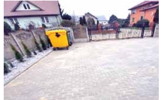
Kostka przed budynkiem świetlicy w Janczewie
